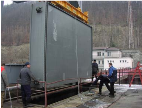
Obr.16 Prenos a spúšťanie hradidlovej tabule
