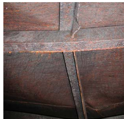
Obr.7 Lokálna plastická deformácia polygonálneho prstenca
