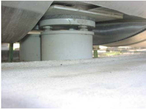
Obr.3 Pätka s vibroizolačnými prvkami
