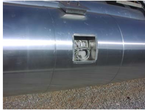
Obr.4 Snímač po zaizolovaní potrubia
