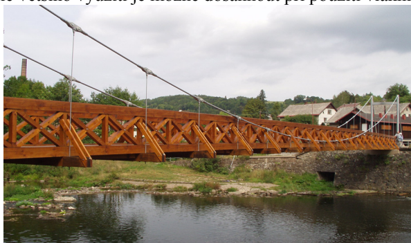
Obr. 1 Visutá lávka v Benešově u Semil, rok dokončení 2002
