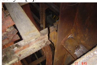
Obr.3 Roztrhnutý profil UE 300
