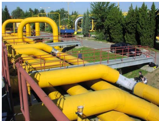
Obr. 13 Miesto s T-tvarovkou na výtlaku TD-6 vybrané pre napäťovú analýzu
