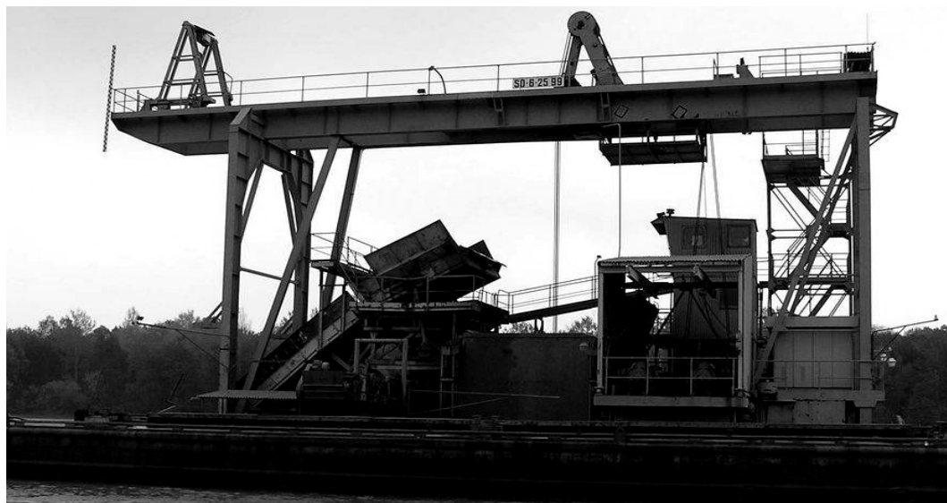
Obr.6 Celkový pohled na jeřáb DB 6,3 v lokalitě Tovačov
