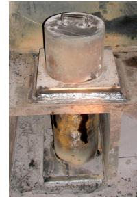
Obr.10 Realizovaný návrh konštrukčnej úpravy v mieste stojana
